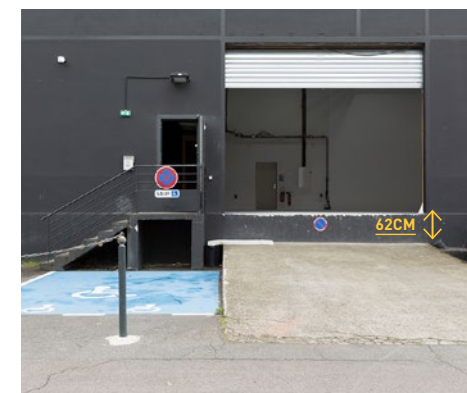
ACCÈS EXTÉRIEUR, MARCHE D'UNE HAUTEUR DE 62CM
