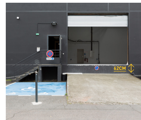
ACCÈS EXTÉRIEUR, MARCHE AU NIVEAU DU RIDEAU MÉTALLIQUE D'UNE HAUTEUR DE 62CM
